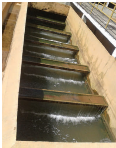
Figura 5 – Processo de Decantação realizado no Sistema Pratagy
